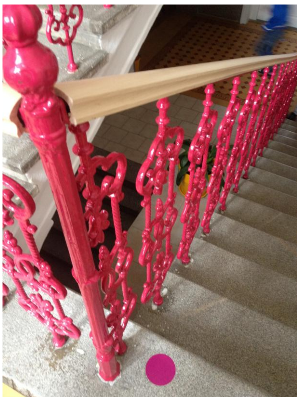
Nově natřené zábradlí.
